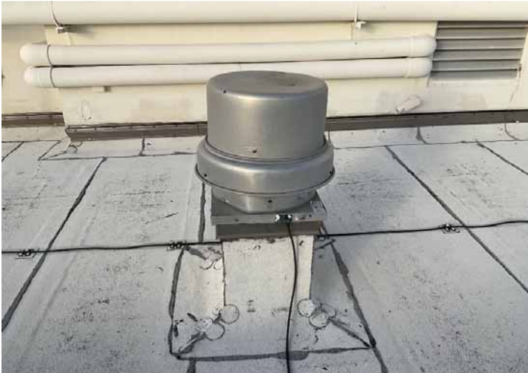
Roof Exhaust Fan
